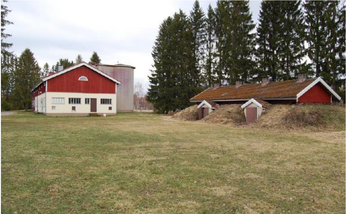
Kuva 21. Maakellari kuvassa oikealla. © Limingan Emäntäkoulun maakellarin kuntoarvion valokuvat, Konsultointi Karhulat Oy 5.6.2025
