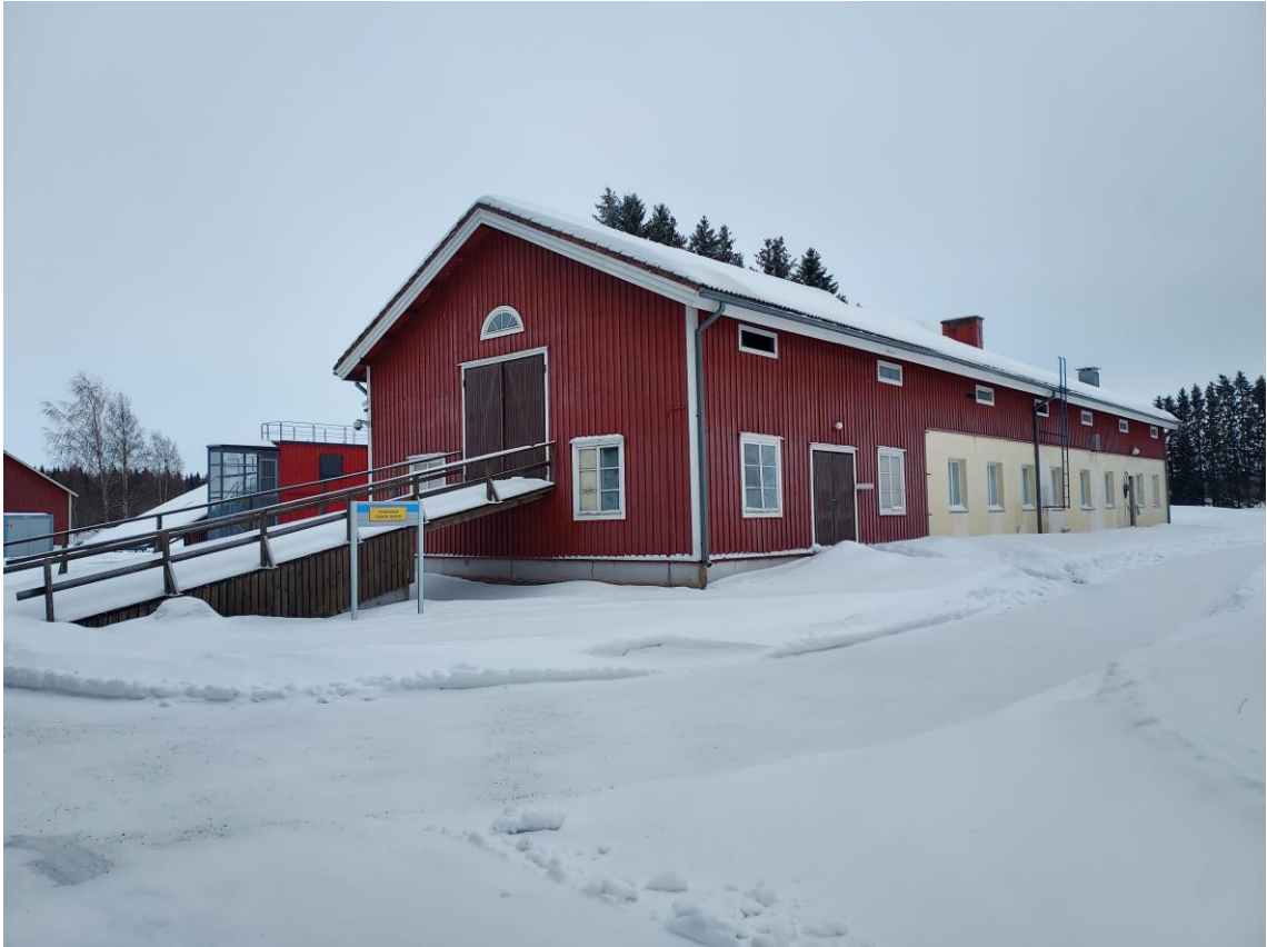
Kuva 19. Emäntäkouluun liittyvä navettarakennus.
