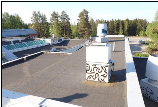
Kuva 91. Yleiskuva tasakatolta. Kermikatteiden kunto yleisesti hyvä.
