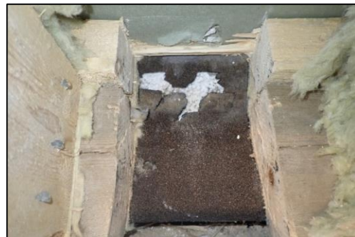
Kuva 66. RA6. Perustuksen päällä bitumikermikaista ja sokkelihalkaisuna EPS-solumuovi. Rungon lämmöneristeessä ei havaittu vaurion viitteitä.
