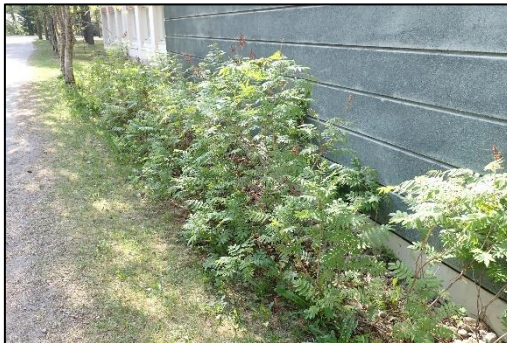
Kuva 17. Kuva tienpuoleiselta sivulta. Rakennuksen vierellä pensaikkaa.
