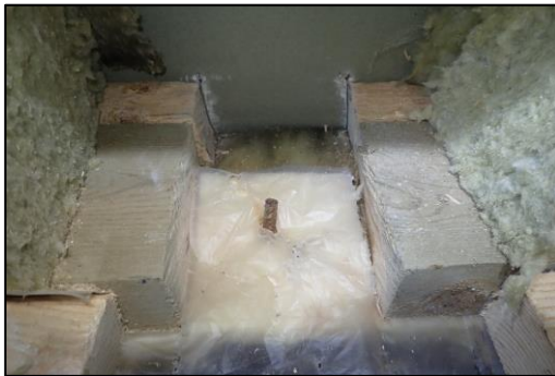
Kuva 71. RA7. Puurakenteet hyväkuntoisia.
