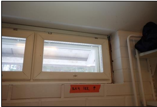
Kuva 59. RA4, tila 124. Ikkunaliittymän avaus.
