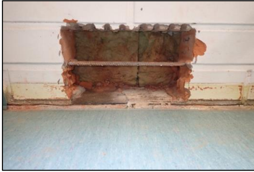
Kuva 49. RA1, tila 124. Avaus ulkoseinän alaosaan. Avauksessa ei havaittu poikkeavaa hajua.
