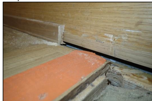
Kuva 33. RA12. Seinäliittymät on listoitettu. Eristetilan tuulettuminen on arvioiden vähäistä.
