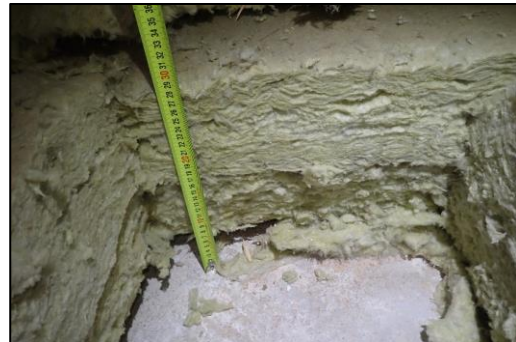
Kuva 104. RA14. Lämmöneristeen paksuus keskialueella 300 mm. Ulkoseinän vierellä on 50 mm lisäeristys.
