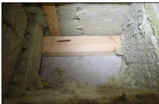
Kuva 105. RA15. Avaus ulkoseinän vierellä. Materiaalit hyväkuntoiset.
