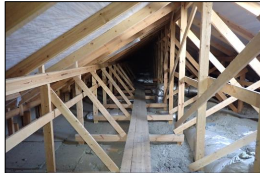
Kuva 102. Yleiskuva yläpohjatilasta. Rakenteet hyväkuntoiset.
