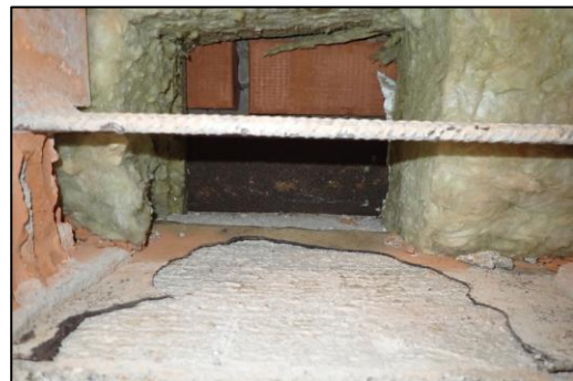
Kuva 56. RA3. Materiaalit ovat hyväkuntoisia. Poikkeavaa hajua tai mikrobikasvun viitteitä ei havaittu.
