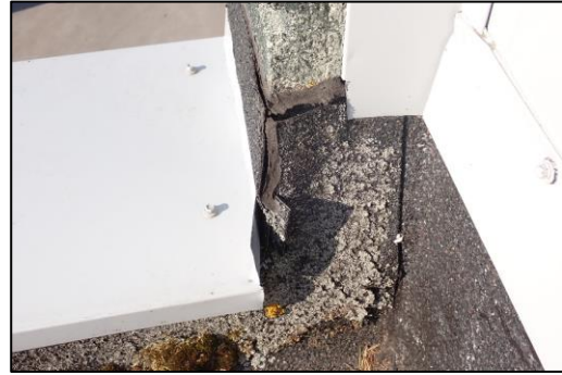
Kuva 94. Seinänostojen nurkissa paikoin kermin saumat ovat irronneet / halkeilleet.
