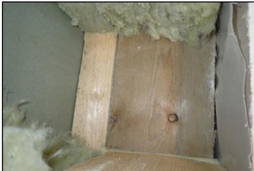
Kuva 77. RA9. Puurakenteet hyväkuntoiset, vaurion viitteitä ei havaittu.
