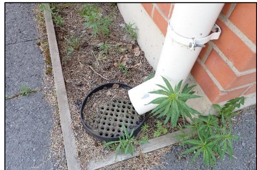
Kuva 14. Pääosin sadevedet on johdettu sadevesikaivoihin.
