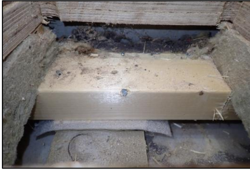
Kuva 34. RA12. Materiaalit ovat hyväkuntoiset. Vaurion viitteitä ei havaittu.
