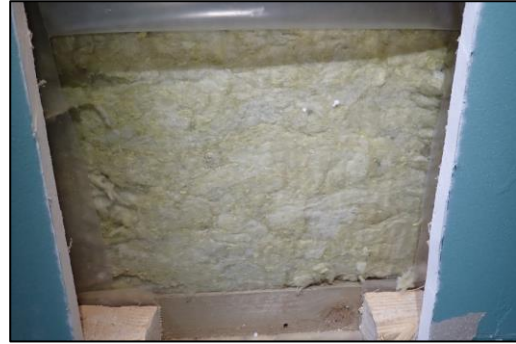
Kuva 70. RA7. Lämmöneriste on hyväkuntoinen, vaurion viitteitä ei havaittu.
