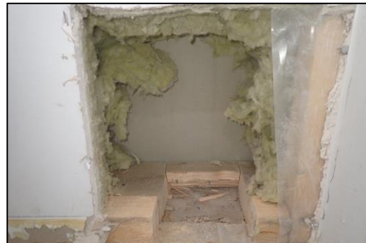
Kuva 74. RA8. Materiaalit ovat hyväkuntoiset, vaurion viitteitä ei havaittu.
