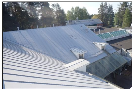
Kuva 86. Yleiskuva peltikatteiselta vesikatolta. Kate on yleisesti hyväkuntoinen.
