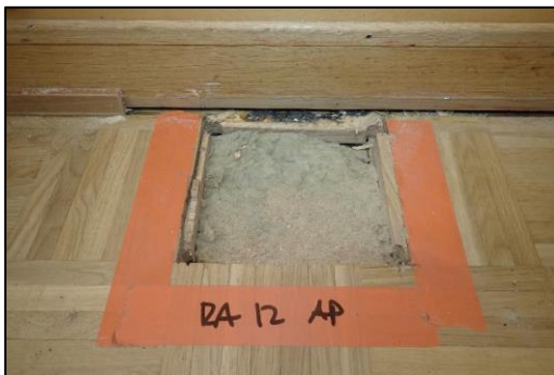
Kuva 32. RA12, tila 125. Alapohjan avaus väliseinän vierellä. Avauksessa ei poikkeavaa tai vaurioon viittaavaa hajua.
