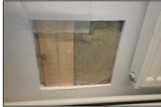
Kuva 76. RA9, tila 104. Avaus seinän alaosaan.
