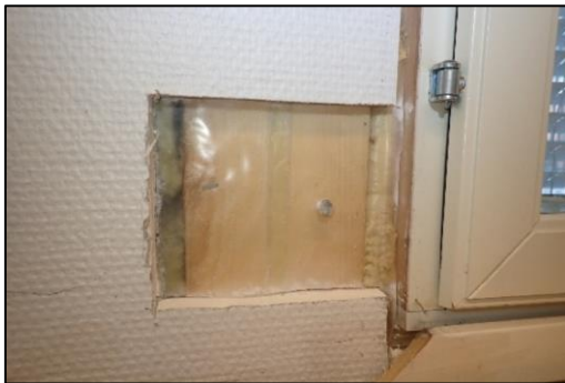
Kuva 79. RA10, tila 104. Ikkunaliittymän avaus.
