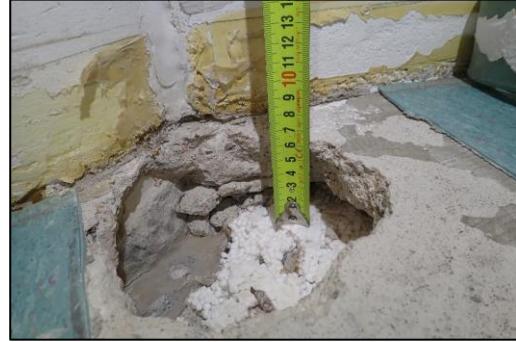
Kuva 29. RA11. Alapohjalaatan paksuus n. 65 mm. Lämmöneristeenä EPS-solumuovi.
