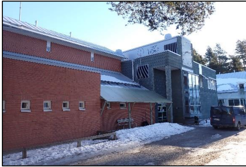
Kuva 9. Yleiskuva rakennuksen vierustalta, rakennuksen sisäpihalta.
