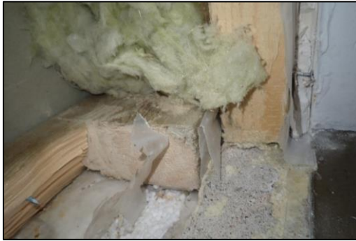
Kuva 75. RA8. Alaohjauspuun alla muovikaista. Höyrinsulkumuovi päättyy perustuksen pintaan. Koolauspuu on asennettu betonia vasten.
