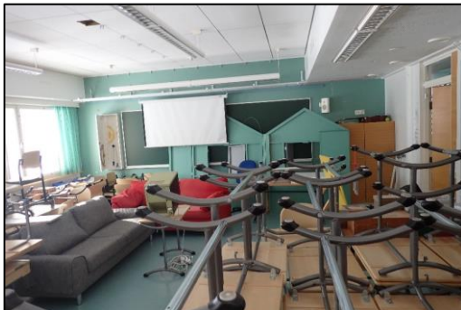
Kuva 3. Tila 105. Paikoin tiloissa oli runsaasti varastoitua käyttötavaraa ja kalusteita.
