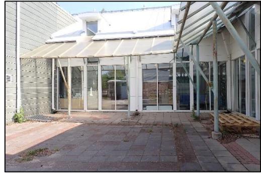
Kuva 10. Yleiskuva rakennuksen vierustalta, rakennuksen sisäpihalta.
