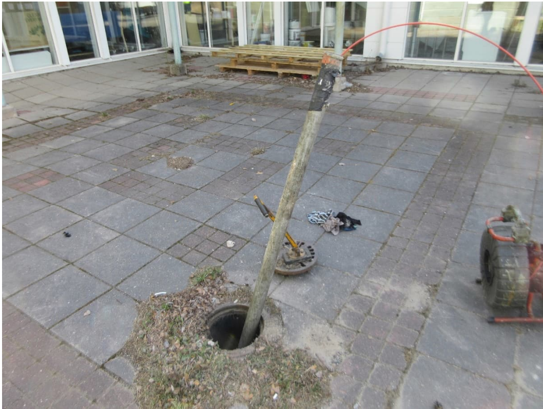
KUVA 6. Välituntikatoksen sadevesikaivo SVK1.
