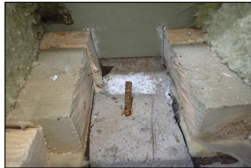
Kuva 72. RA7. Perustuksen päällä bitumikermikaista.
