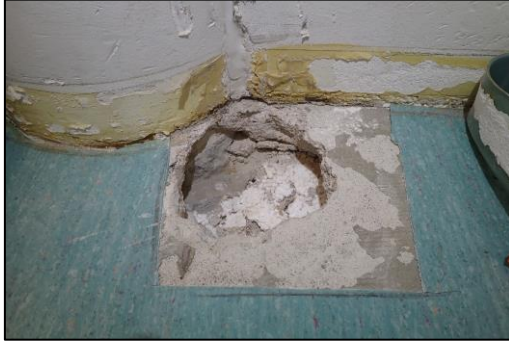
Kuva 28. RA11, Tila 109. Alapohjan avaus väliseinän ja pilarin liittymässä.
