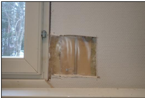
Kuva 61. RA5, tila 110. Ikkunaliittymän avaus.
