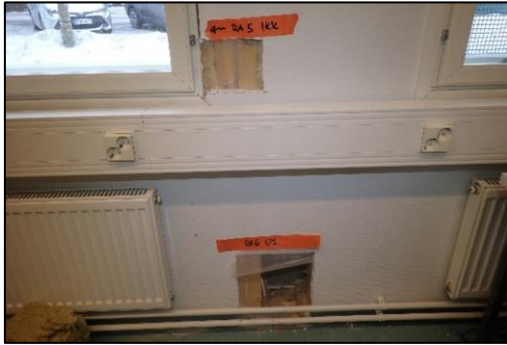
Kuva 63. RA6, tila 110. Avaus seinän alaosassa.
