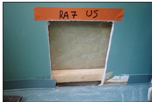
Kuva 68. RA7, tila 109. Avaus seinän alaosassa.
