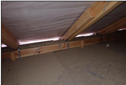
Kuva 103. Yläpohja tuulettuu räystäiden kautta.
