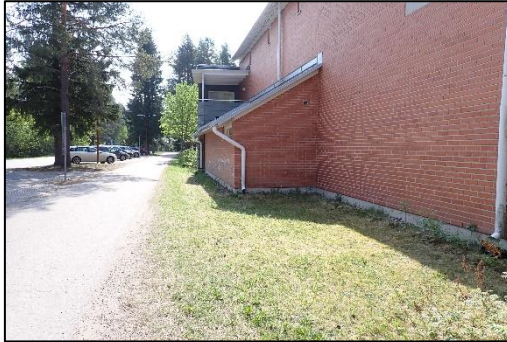
Kuva 15. Yleiskuva rakennuksen tienpuoleiselta sivulta. Maanpinta on tasainen ja osin kallistaa rakennusta kohti.
