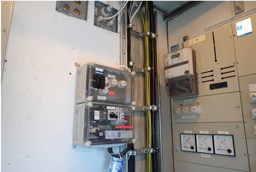
KUVA 9. Sadevesipumppaamon pumppukeskus.
