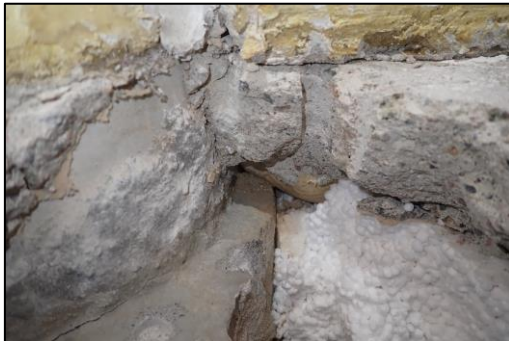
Kuva 30. RA11. Tiiliseinä asennettu laatan päälle.
