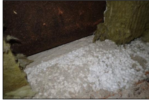
Kuva 52. RA1. Sokkelihalkaisuna EPS-solumuovi. Tuulensuojavillan ja ulkomuurauksen välissä vaihteleva ilmarako.
