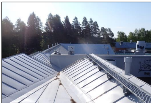
Kuva 85. Yleiskuva peltikatteiselta vesikatolta. Kate on yleisesti hyväkuntoinen.
