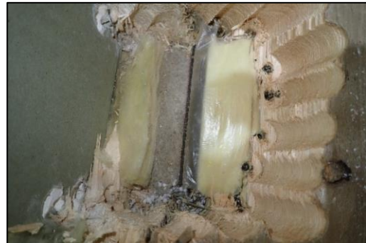
Kuva 78. RA9. Alaohjauspuun alla mineraalivillakaistassa poikkeavaa mikrobikasvua. Vaurioon viittaava hajua ei havaittu.
