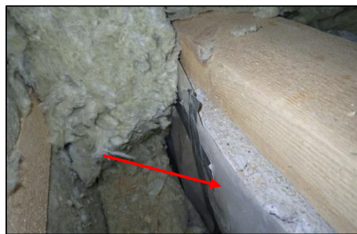
Kuva 106. Ulkoseinän höyrynsulkumuovi on nostettu yläpohjan pintaan.
