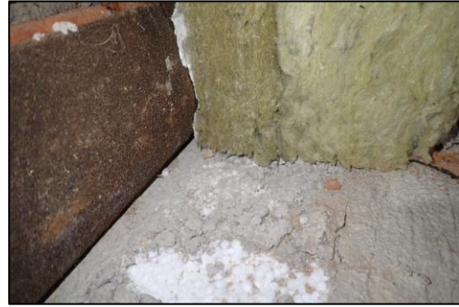
Kuva 58. RA3. Sokkelihalkaisuna EPS-solumuovi.
