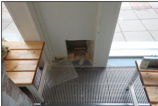
Kuva 73. RA8, tila 103. Avaus seinän alaosassa.
