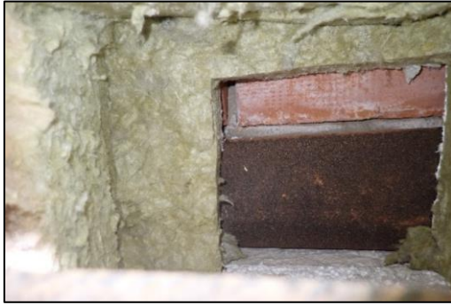
Kuva 51. RA1. Mineraalivillat hyväkuntoisia, ei vaurion viitteitä.
