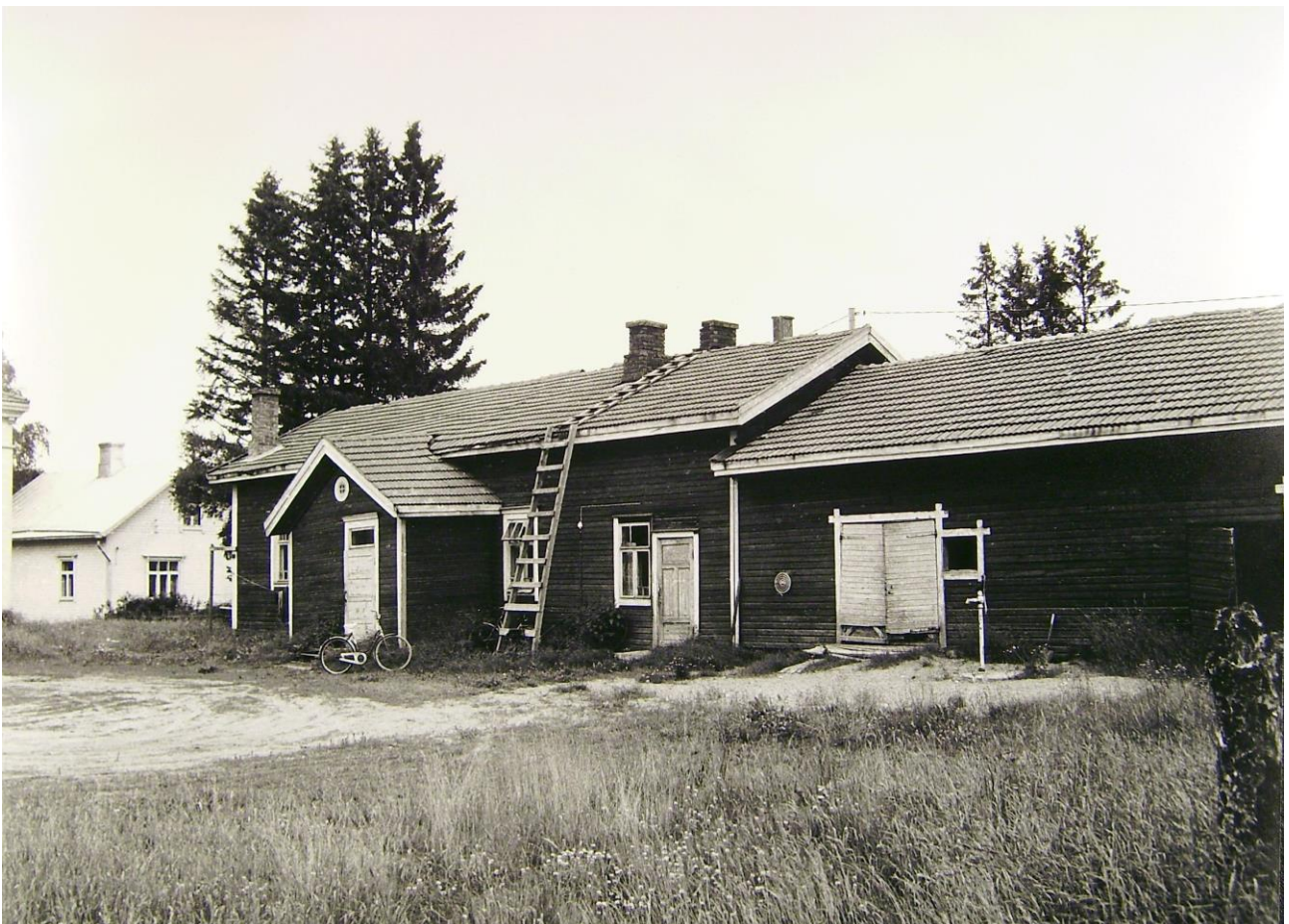
KUVA 3. Kunnanhuonerakennus ennen purkamistaan 1970-luvun loppupuolella. Kokoushuoneena toimi talon joen puoleinen pääty, joka oli myös käsityöluokkana.
