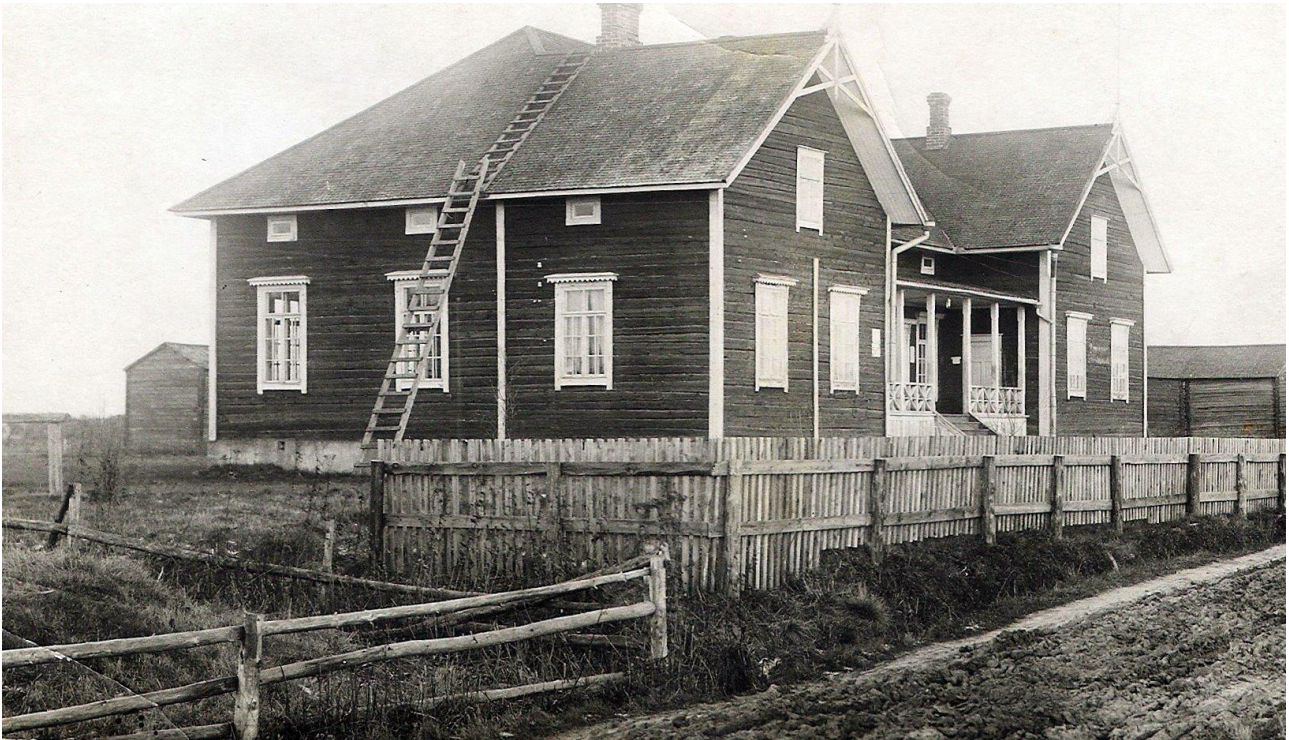
KUVA 4. Vuonna 1914 valmistunut Kunnallistalo vielä vuoraamattomana, luultavasti 1920-luvulla. Takana näkyy hirsinen aittarakennus, oikeassa kulmassa Nikulan puojia.
