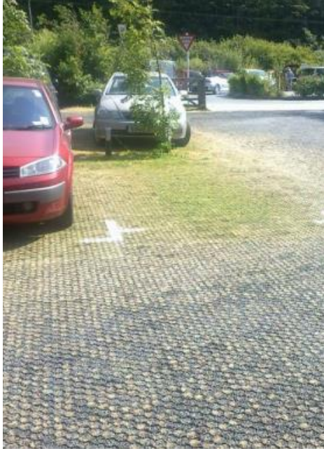
Kuva 6-2 Kennorakenne pysäköintialueella
