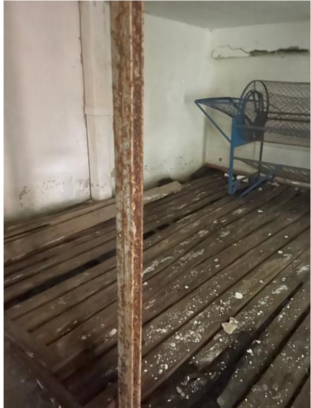
Kuva 34. Ruostunut teräspilari
