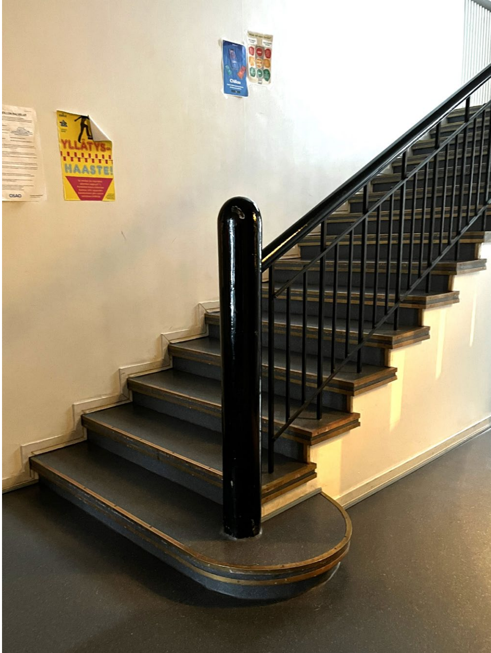
Pääporras ensimmäisessä ja toisessa kerroksessa.
