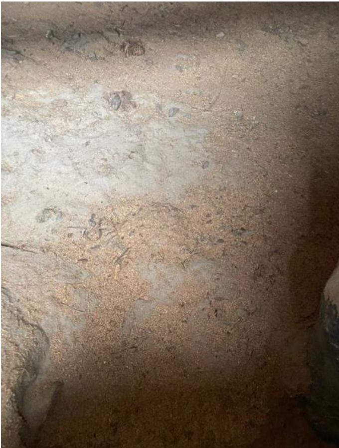
Kuva 17. Sahanpurueristeessä kosteusjälkiä
