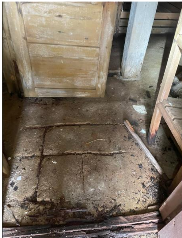
Kuva 30. Alapohjan teräsverkko näkyvissä.
