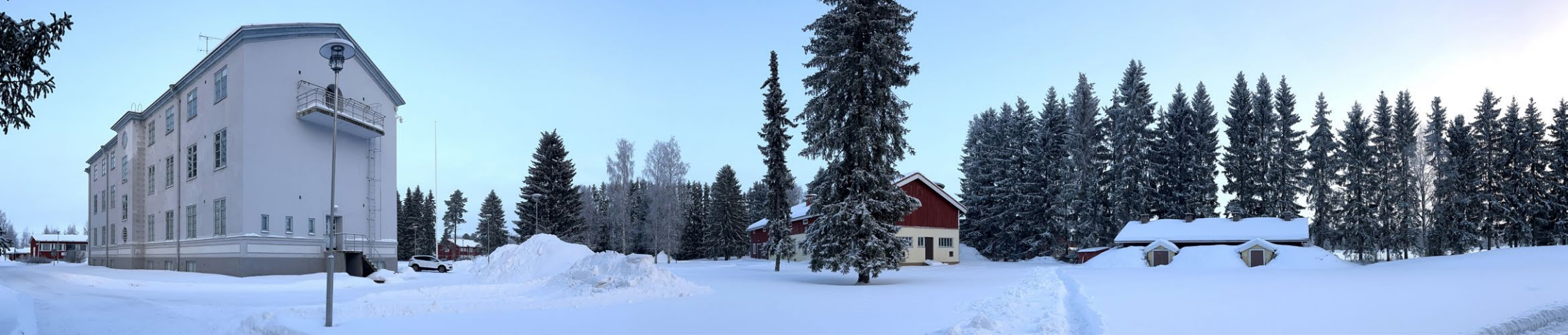
Näkymä nykyiseltä parkkipaikalta päärakennuksen, navetan ja maakellarin suuntaan.
