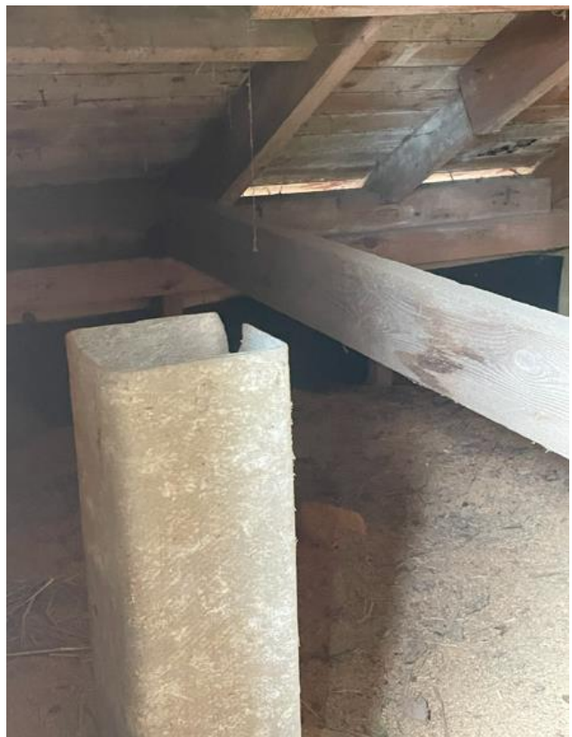
Kuva 23. Putki maakellarin huoneesta yläpohjaan. Kuva 24. Ilmaputki yläpohjassa
