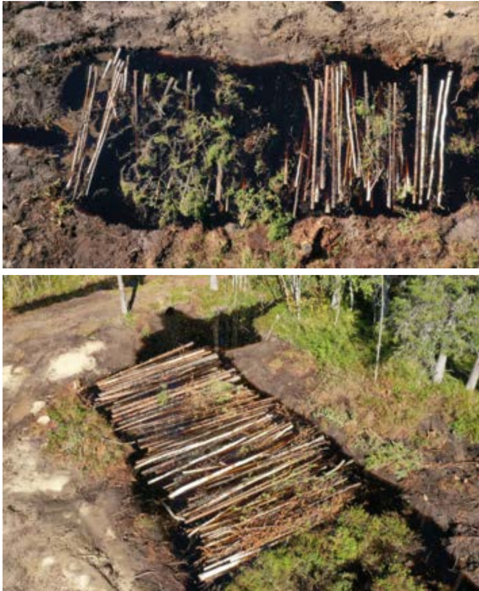
Kuva 31. Rankapuista ja latvuksista tehtyjä puukasetteja pian rakentamisen jälkeen.
