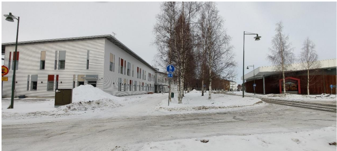
Kuva 10 Terveyskeskus ja kirjasto rajaavat Liminganraittia.
