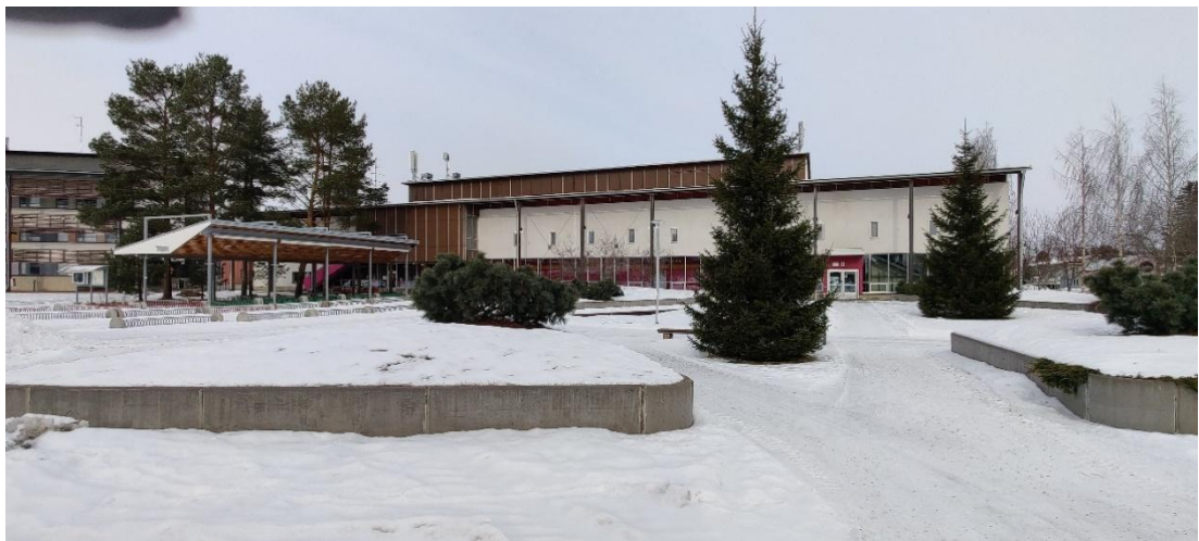
Kuva 12 Liikuntahallin etupiha on rakennettu puistomaiseksi aukioksi.
