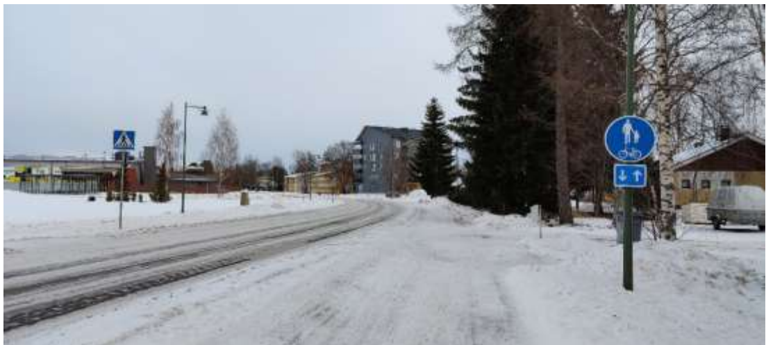
Kuva 13 Meijerintien varrella on monipuolista ja mittakaavaltaan erikokoista rakentamista.
