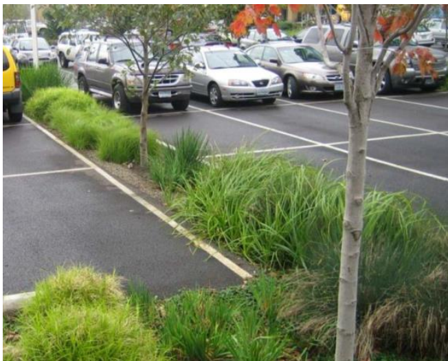
Kuva 6-3 Esimerkki biosuodatuskaistasta pysäköintialueella
