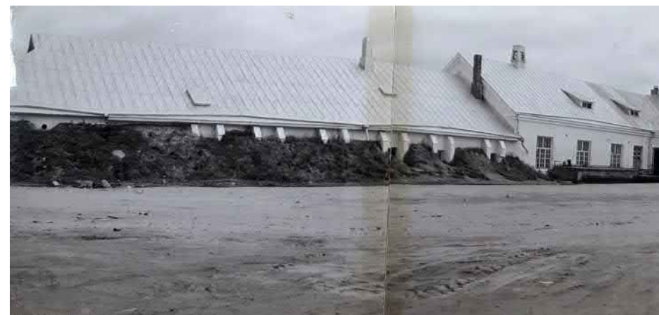
Kuva 49. Juustolasiiven maavallilla tuettu rakenne. (Limingan Osuusmeijerin kuva-arkisto)
