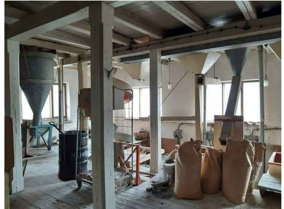
Kuva 56. Myllyn ullakkoa elokuussa 2021. Tila on valoisa ja väriykseltään myös vaalea. Tiiliseinät on rapattu ja maalattu valkoiseksi. Tilassa on sirot vaaleat puupilarit -ja palkit, joissa on myös kaunista detaljointia. Mylly ei ole muussa käytössä kuin varastona ja on kylmillään. Sen alkuperäinen asu on säilynyt.
