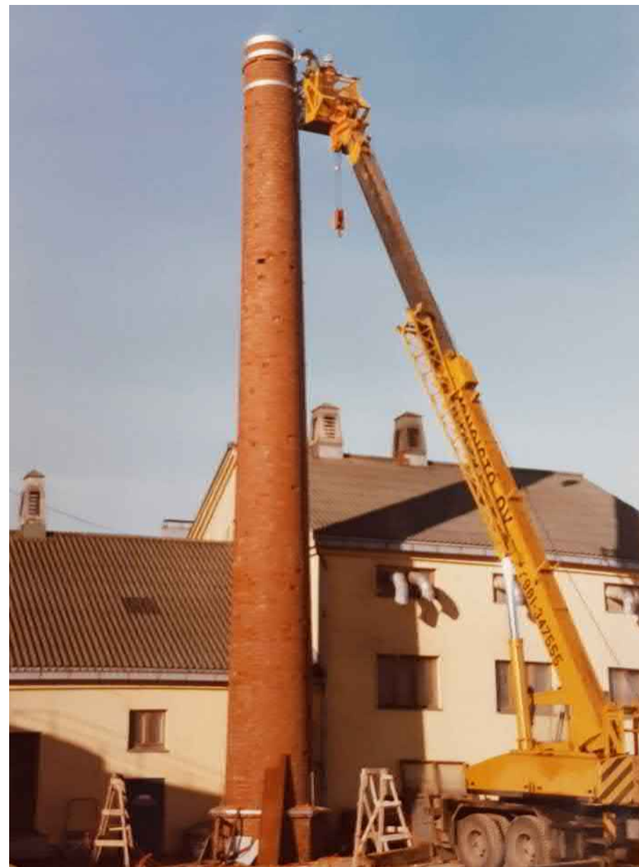
Kuva 32. Meijerin piipun purkutöiden aloitus. Postikortti aiheesta on vuoden 1980 heinäkuulta. Piippu oli punatiilillä verhoiltu. (Limingan Osuusmeijerin arkisto)
