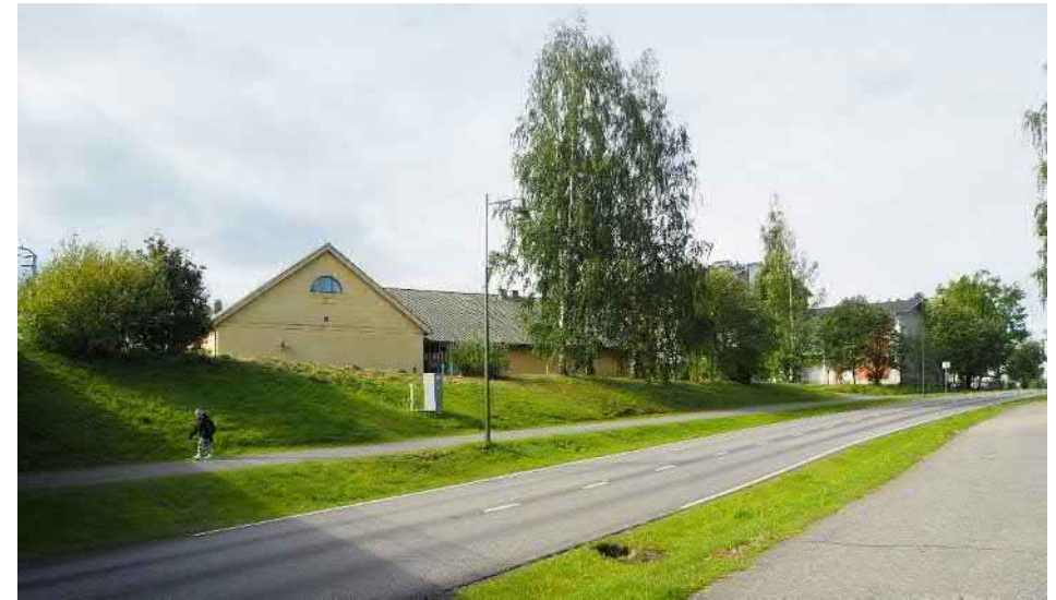
Kuva 36. Osuusmeijerin harkkorakenteinen pääty rautatiealikulun suunnasta Kauppakadun varresta.
